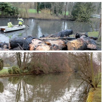
Avant et après nettoyage
