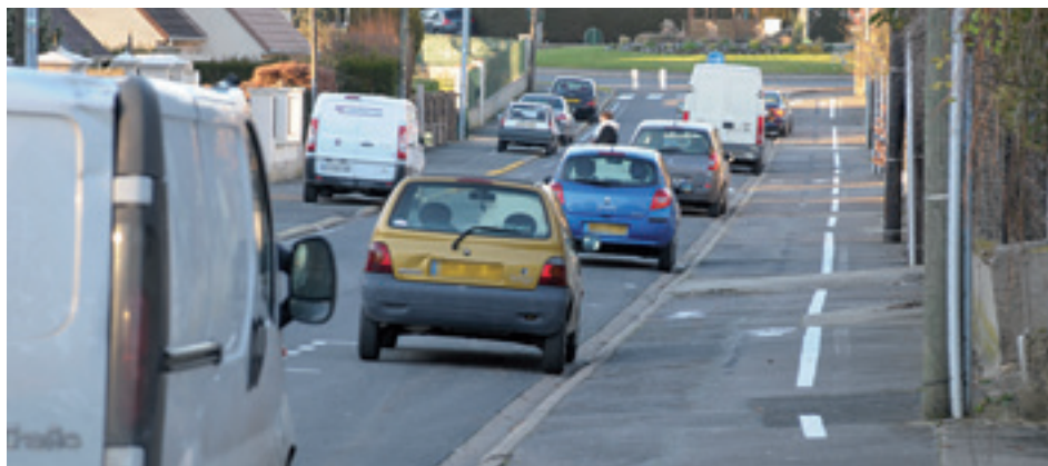
Rue Alphonse Combe : création d'une piste cyclable.
