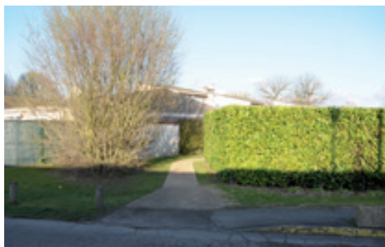
Résidence Vincennes : réfection d'un trottoir et création d'un chemin rue de la Doutre.
