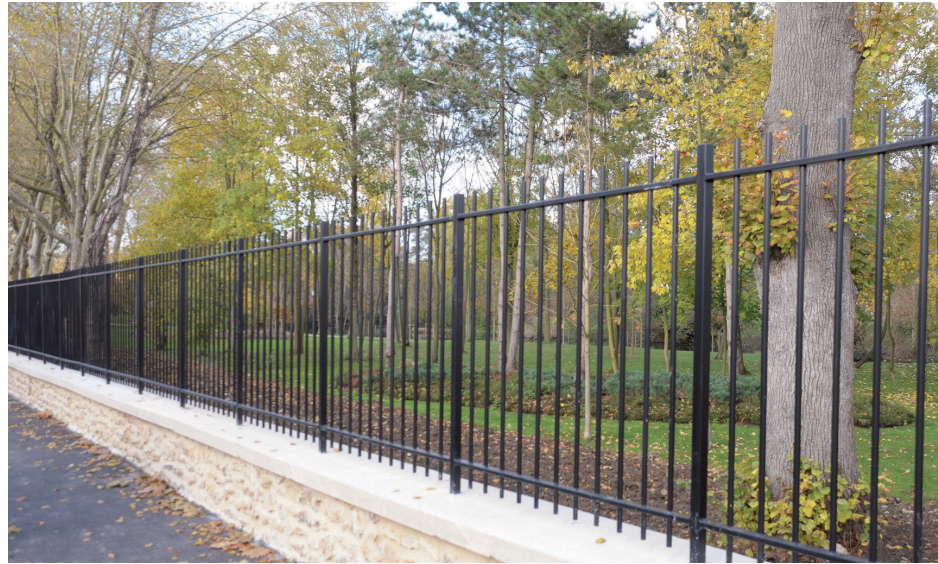
Le nouveau mur
