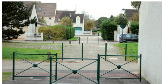
Place Jean Giono : sécurisation du cheminement des piétons et de la circulation des deux roues.
