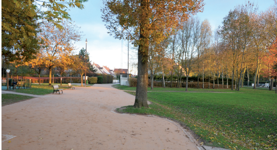
Parc Oudry : réaménagement de l'ensemble des allées.
