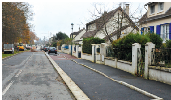
Le premier tronçon de la rue Alphonse Combe est réalisé
