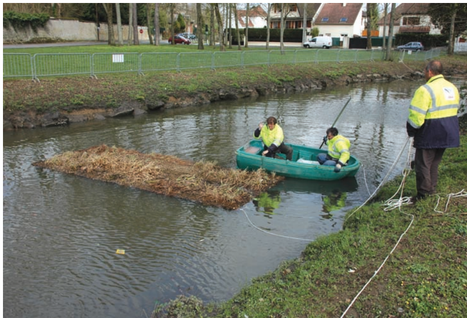
La mise en place des supports flottants
