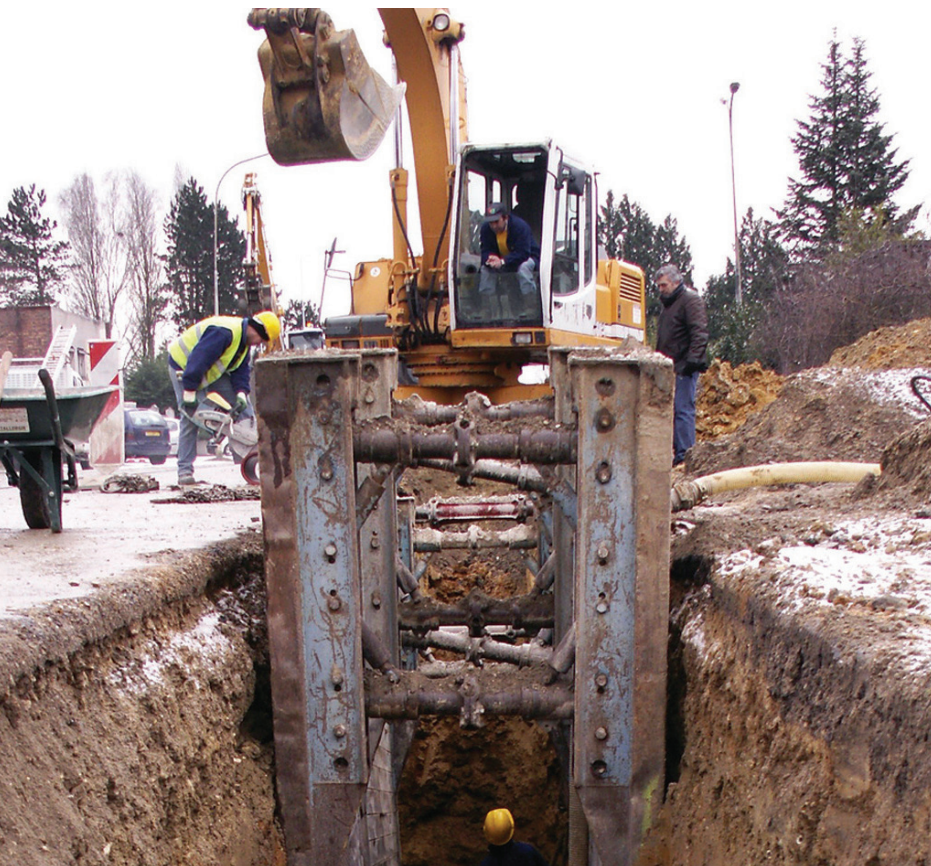
Les travaux d'assainissement de l'avenue Robert Schumann
