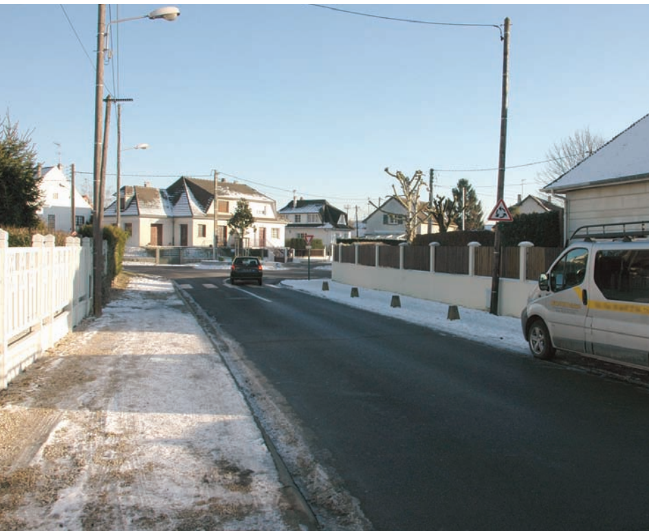
La rue Ronsard avant et après les travaux
