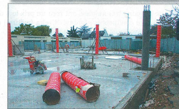
Le nouvel espace de restauration, au début et à la fin des travaux.
