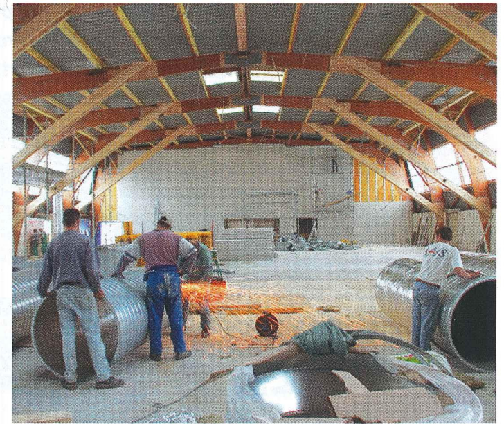
Les travaux de la salle Besson
