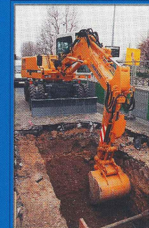
TERRASSEMENT DEMOLITION LOCATION D'ENGINS ET CAMIONS
