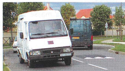
Pose de ralentisseurs avenue de la Doutré
