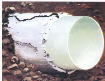
La canalisation abimée est dotée d'un fourreau intérieur en polymères sans qu'il soit nécessaire d'ouvrir une tranchée. La légère perte de section est compensée par un meilleur coefficient de glissement des effluents.
