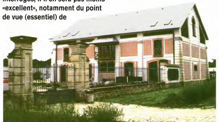
Au printemps, professeurs et élèves s'installeront dans ce bâtiment de 345 m 2 au sol, situé à droite du corps central de la ferme (côté Intermarché).
