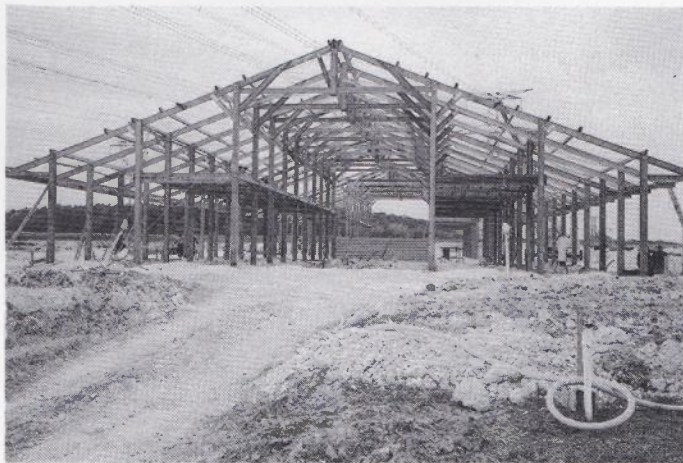
Construction du Centre équestre.
