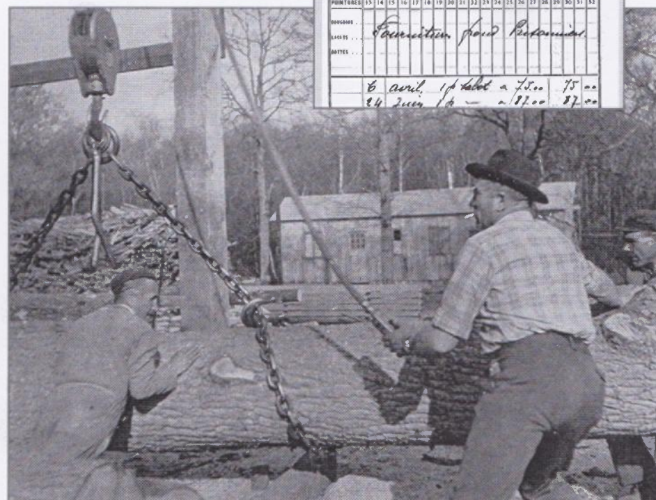
La scierie Poulet, se trouvait à la sortie du village en allant vers Gretz (à proximité de l'actuel carrefour Danton). On voit sur ce cliché, pris il y a une quarantaine d'années, le contremaître, M. Stéphane Scolna, en train de manipuler une grume de bois à l'aide d'un palan électrique. Les ouvriers qui participent à l'opération sont sans doute des espagnols installés à Ozoir à l'issue de la guerre civile qui ravagea leur pays en 1936-1937.
