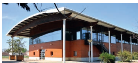
Aménagement d'une salle multi-activités et d'une salle de boxe au gymnase de la Brèche-aux-Loups
